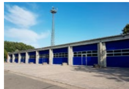
Die Fahrzeughalle mit erneuerten Toren.
