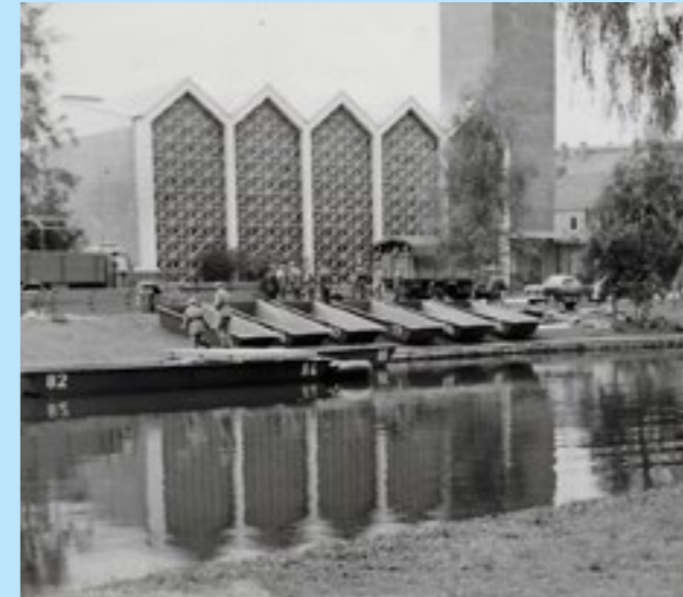
Aufbau einer Plattform aus Pontons zur Poggendorfer Woche 1963
