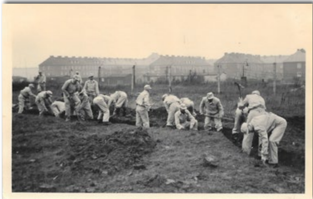
Erdarbeiten in Katzenheide
